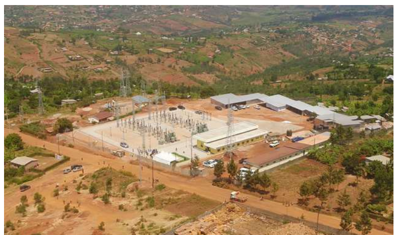
ルワンダ・キガリ市ガソギ変電所(2022年8月完工)
