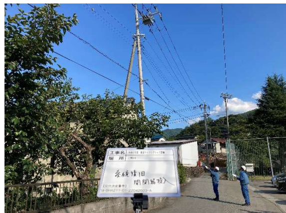
(区分開閉器操作訓練)
