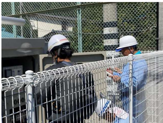
(非常用発電機操作訓練)
