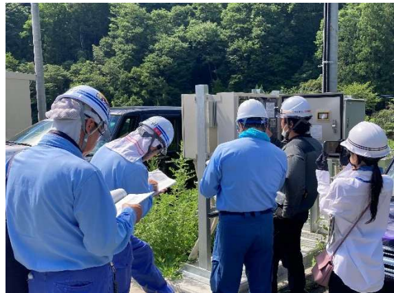
(太陽光設備整定値変更訓練)
