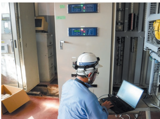
図3 現地試験（トロ口変電所；FRへの電流・電圧入力）
