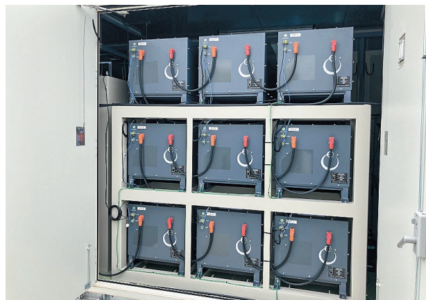
図2 大容量リチウムイオン蓄電池設備 蓄電池ユニット
