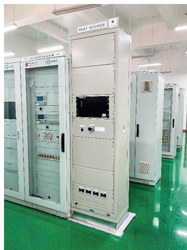
図2 オシログラフデータ記録装置（ドンボン変電所）
