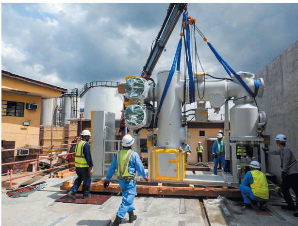
図 3 132 kV GIS（据付作業中）
