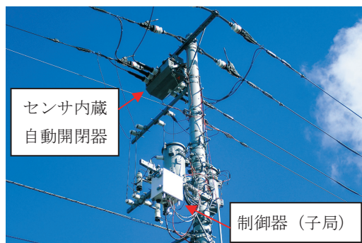
図4 現地設置の様子
