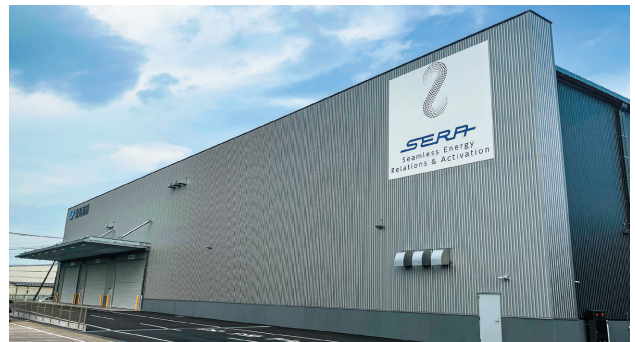
図1 スマートメーターアセンブリセンター外観
