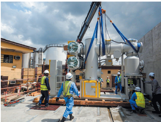
図 3 132 kV GIS（据付作業中）
