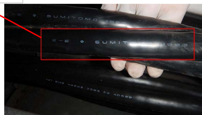
写真2. CVケーブル
