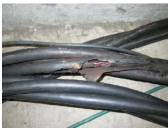
写真3. 絶縁破壊したケーブル
