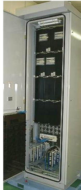
図9 配電用変電所デジタル保護制御装置(バンク制御盤)
