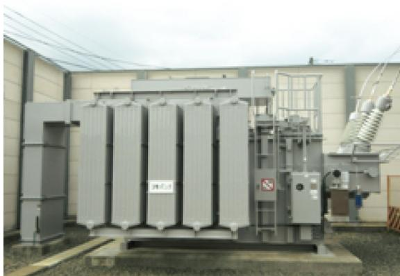
図1 屋外配電用20 MVA 変圧器(最新器)
