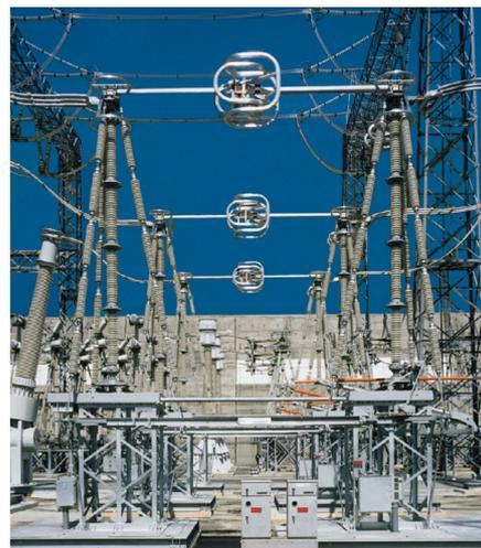
図6 550 kV 4,000 A 高信頼度形水平中心一点切断断路器
