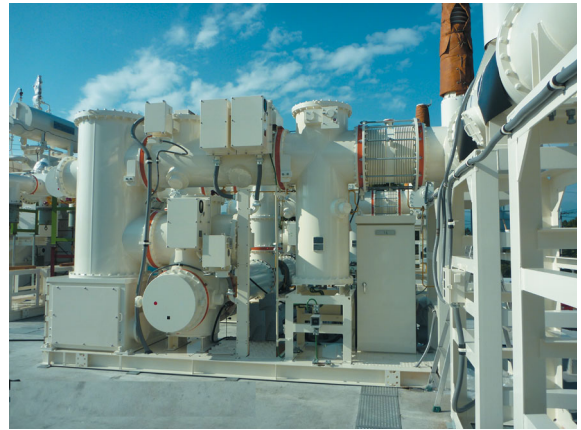
図 4 168 kV 縮小形 GIS 変圧器直結
