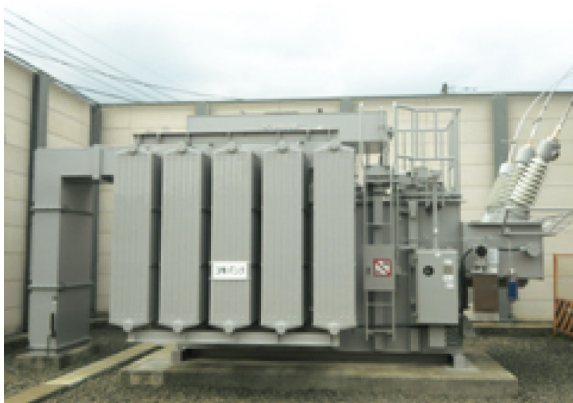
図1 屋外配電用20 MVA 変圧器（最新器）
