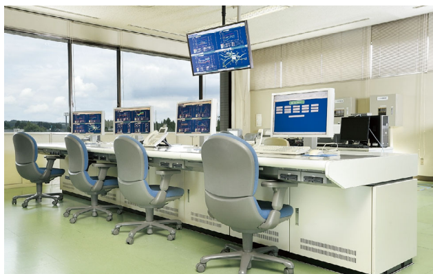
図8 水処理場監視システム例
