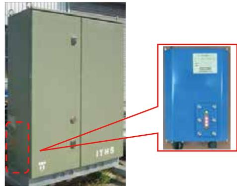
図4 ITHS/光通信ユニット外観図
