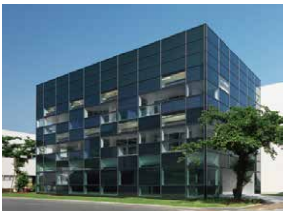
図1 ZEB実証棟外観
