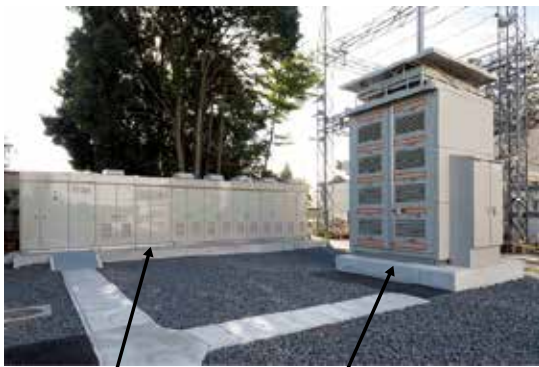
200kWNAS電池用PCS 200kWNAS電池 図5 200kWNAS電池用PCSおよび200kWNAS電池
