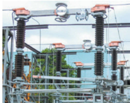
図 1 タイプテストを実施した接地装置付断路器
