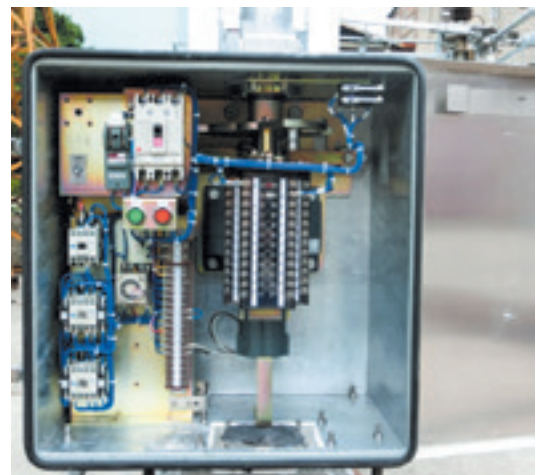
図 2 タイプテストを実施した電動操作装置
