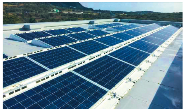
図 2 新島中学校太陽光発電設備
