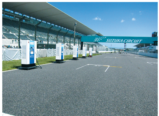
コース上に設置された急速充電器
