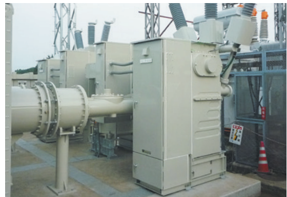
図 4 小山事業所設備向け 新形 C-GIS の外観
