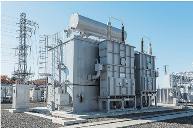
図 1 154 kV 200 MVA 変圧器外観
