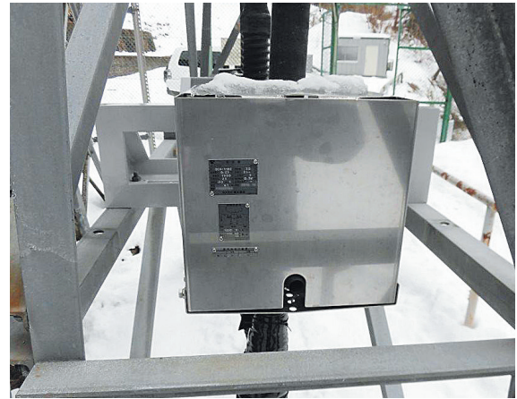
図2 封印用カバー取付状況
