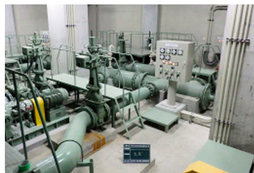
図5 汚水ポンプ室完成状況
