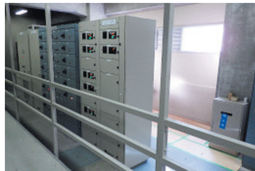
図4 電気室完成状況
