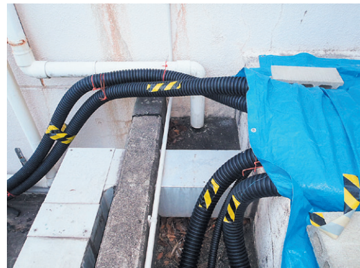
図3 沈砂池仮設状況
