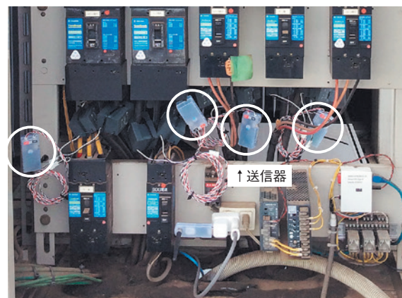
図 5 現場取付状況 送信器
