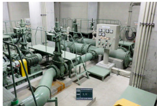
図5 汚水ポンプ室完成状況
