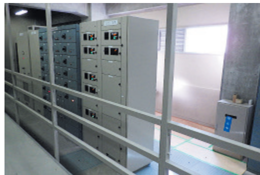
図4 電気室完成状況
