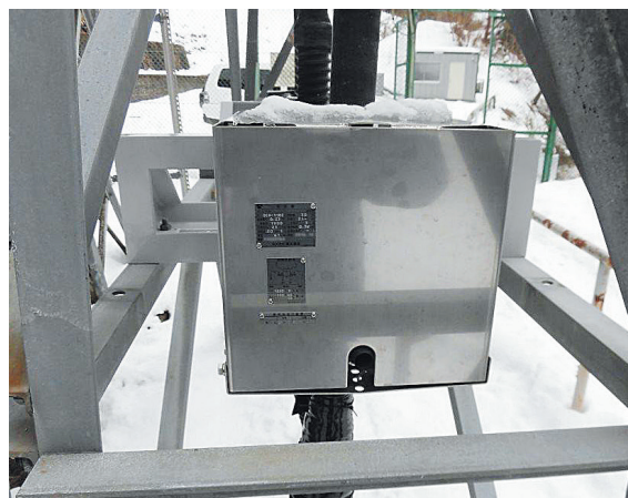
図 2 封印用カバー取付状況
