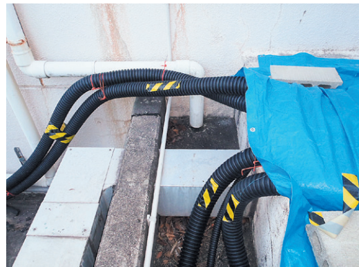
図3 沈砂池仮設状況
