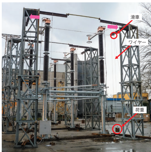
図 6 端子荷重試験設置状況
