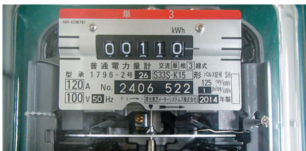
図 1 電力量計の写真
