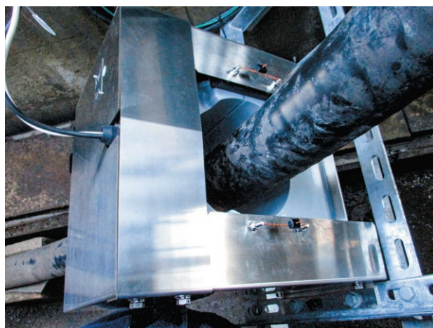
図 2 封印カバー設置状況
