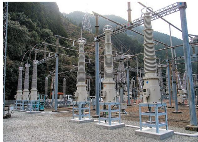
図1 220kV自立形ガスEVTの設置状況
