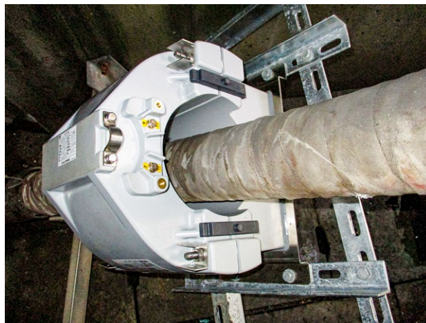
図 1 CT 設置状況
