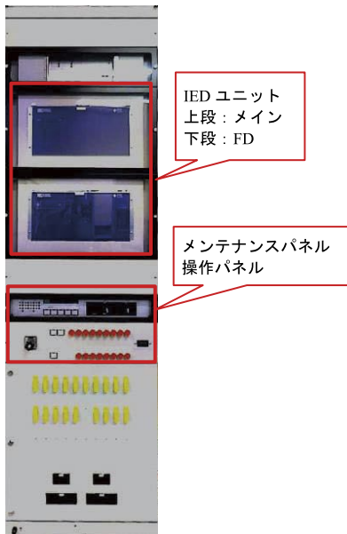
図3 中央装置の外観
