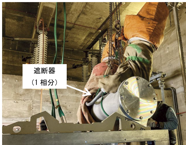
図5 新形タンク形ガス遮断器の分割例
