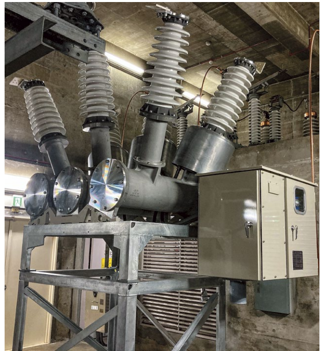
図1 新形タンク形ガス遮断器 (写真は磁器がい管・塗装レス仕様の屋内変電所適用器)
