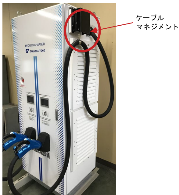
図 4 ケーブルマネジメントが取り付けられている本器の写真
