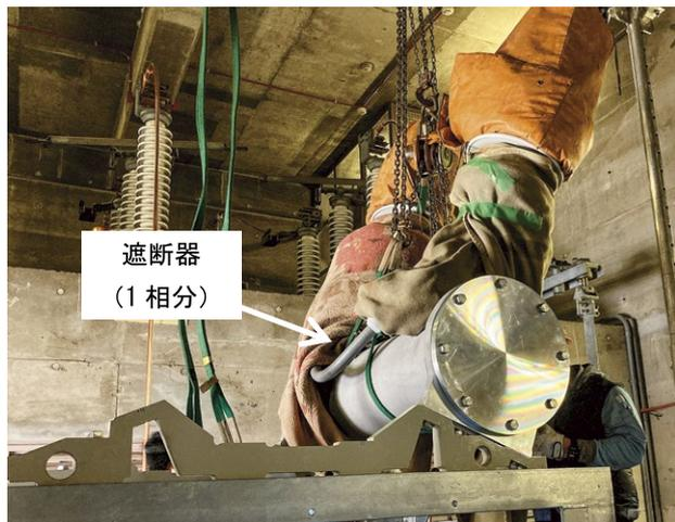
図5 新形タンク形ガス遮断器の分割例
