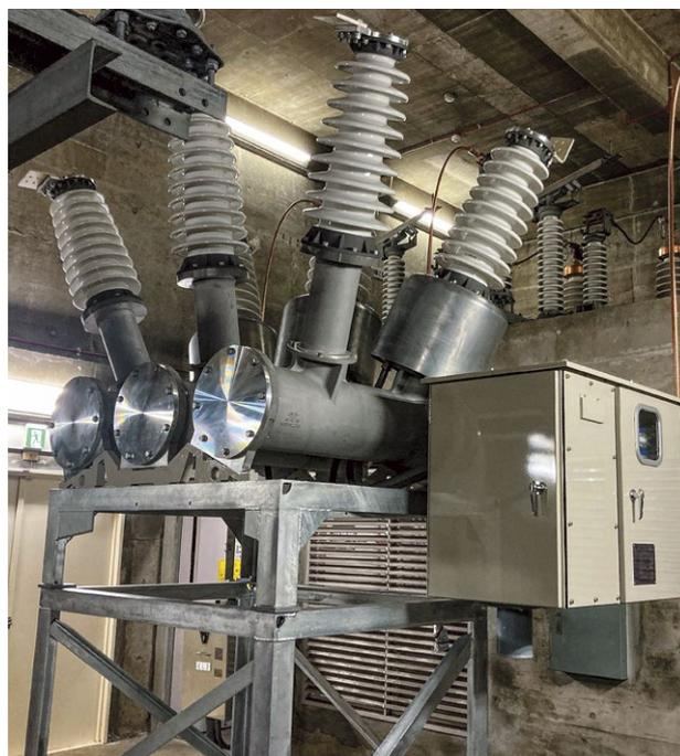
図1 新形タンク形ガス遮断器
