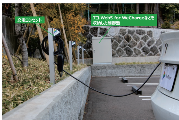
図4 WeChargeの施工例
