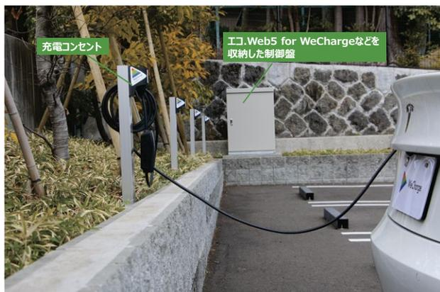
図4 WeChargeの施工例
