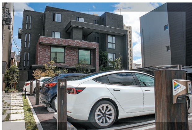
図 3 充電コンセントの施工例
