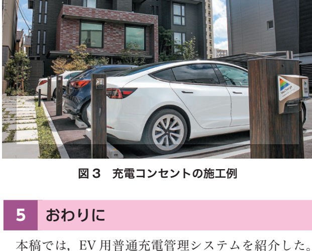
図 3 充電コンセントの施工例
