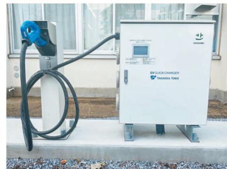
図 5 15 kW モデル中容量急速充電器 自立設置の例
