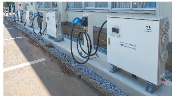
図 4 新たに設置した 15 kW モデル中容量急速充電器 (手前) と普通充電器, 普通充電コンセント (奥)
