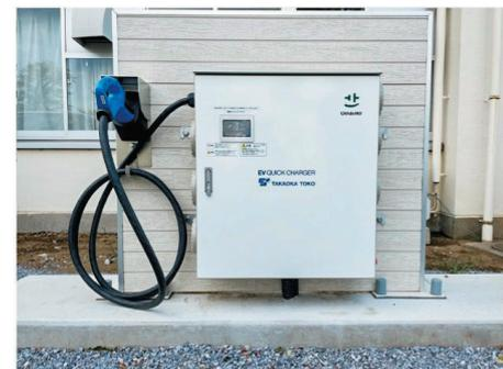
図 6 15 kW モデル中容量急速充電器 壁掛け設置の例
