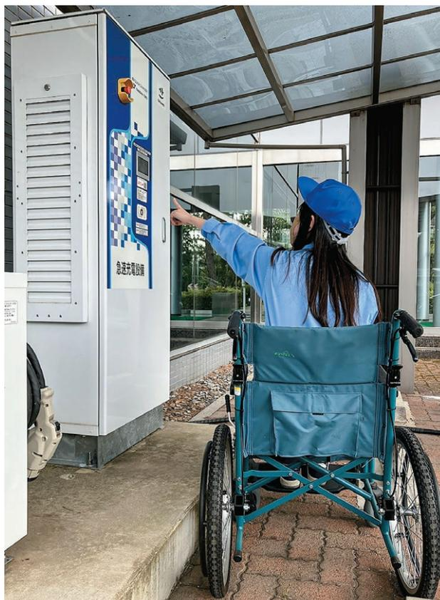
図1 UD化前の機器の車椅子利用者による操作検証
