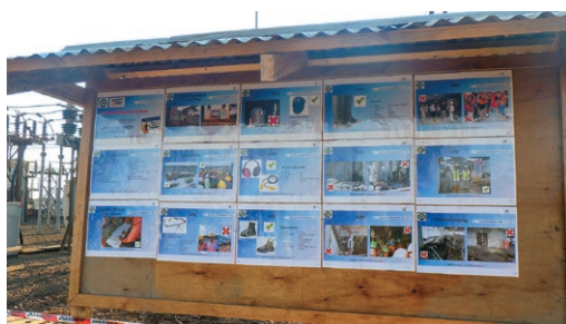
図 5 安全管理を促す掲示(カネンゴ変電所)
