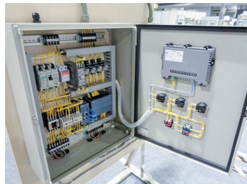
競技課題完成写真：配電盤・制御盤組立
