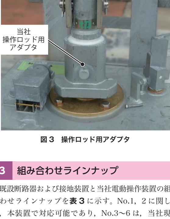
図 3 操作ロッド用アダプタ
