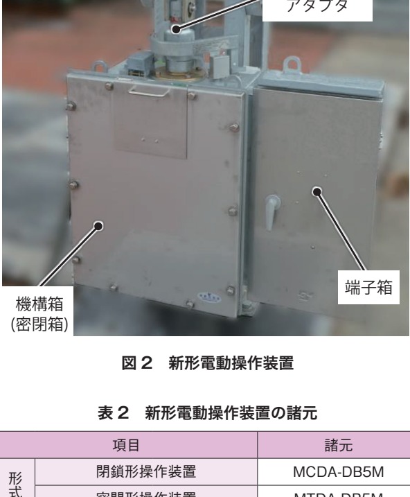
図 2 新形電動操作装置
