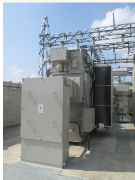
＜小山地区に設置されたパームヤシ脂肪酸エステル変圧器＞
