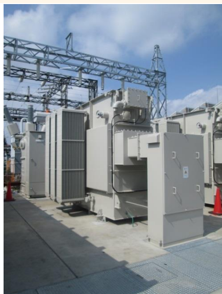
＜小山地区に設置されたパームヤシ脂肪酸エステル変圧器＞
