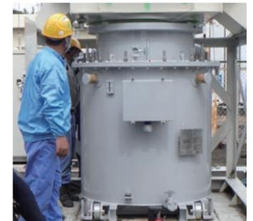
22kVモールド形計器用変圧器
