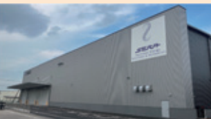
(図1)計器センター外観
