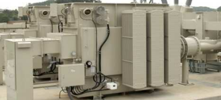
①植物由来の油を使用したパームヤシ脂肪酸エステル変圧器
